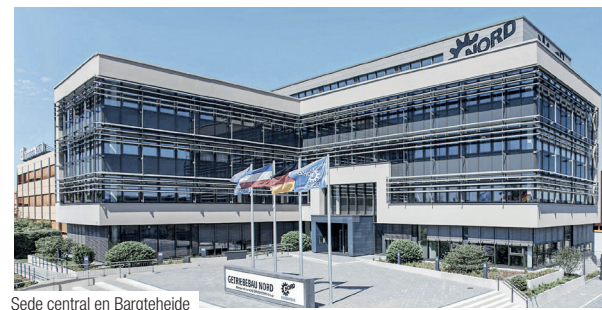
Sede central en Bargteheide
