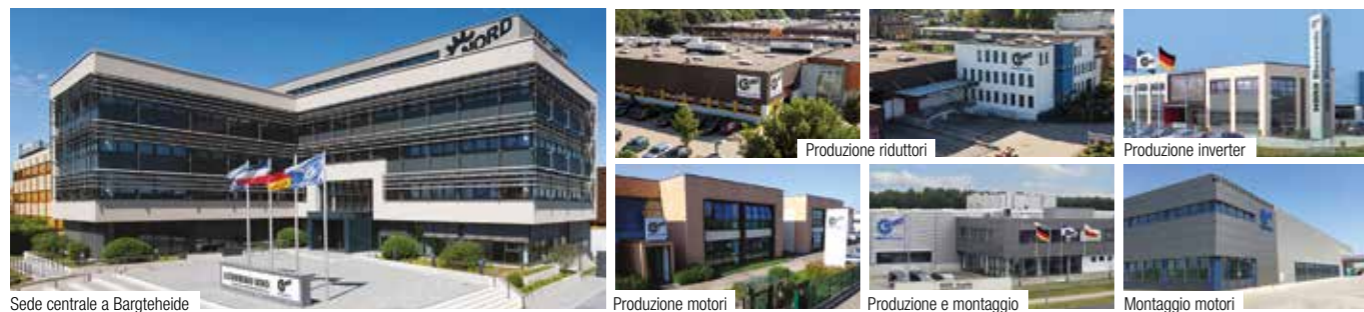
Sede centrale a Bargteheide
