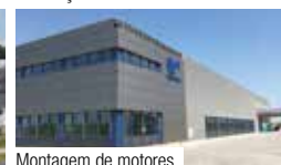
Montagem de motores
